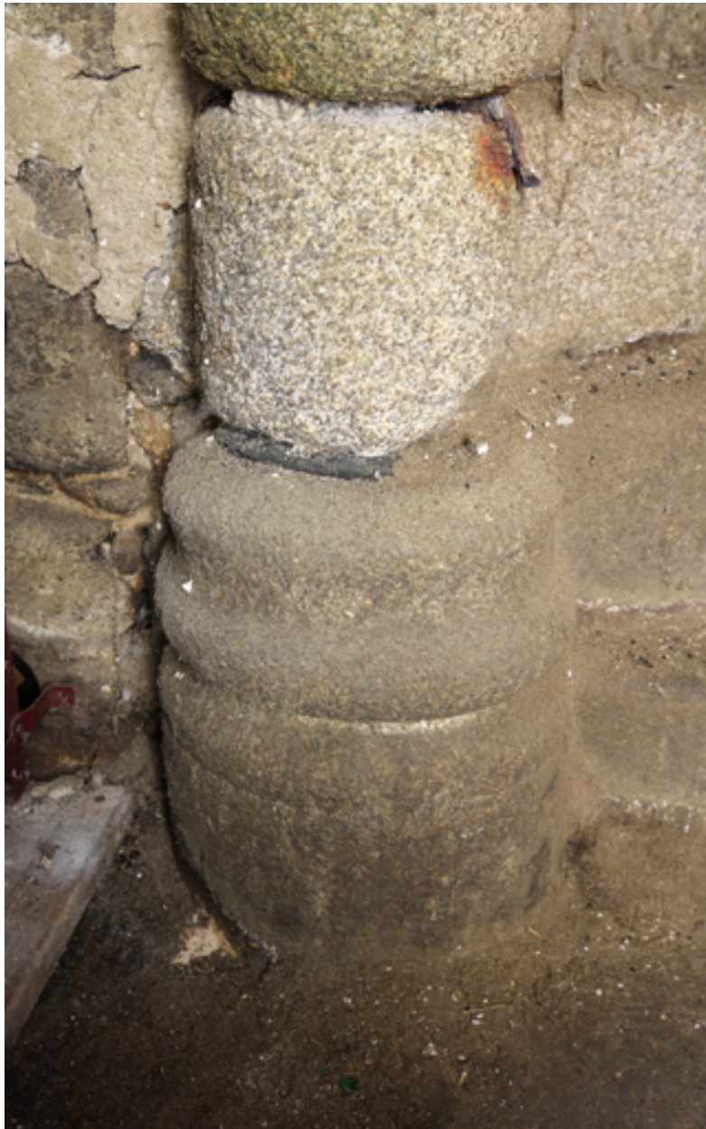
Logis. Tour d'escalier. 1er niveau. Détail de la base du noyau de l'escalier.
