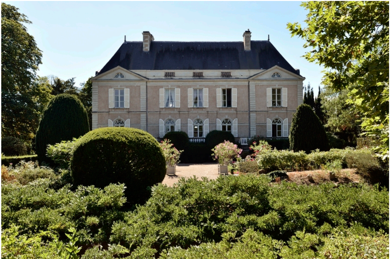
Vue de la façade nord.
