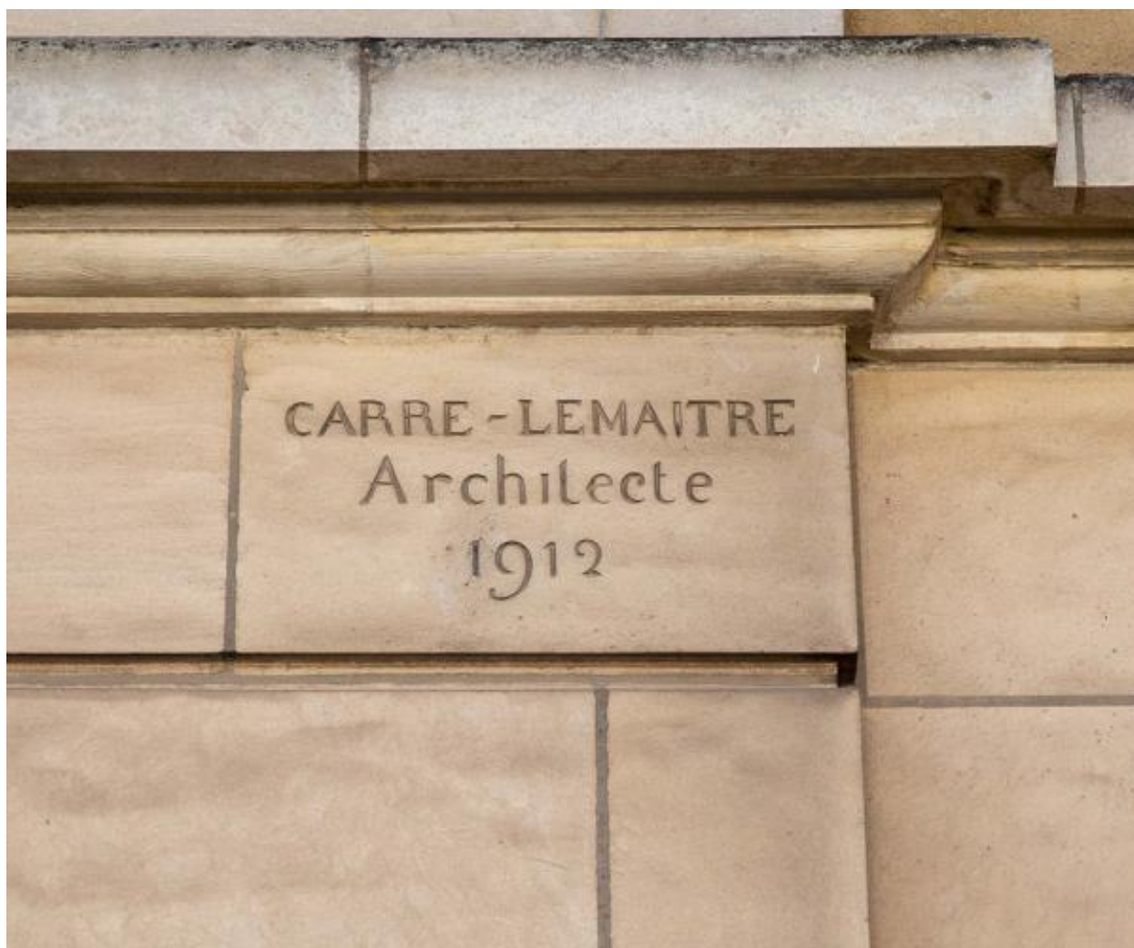
Vue de la plaque d'architecte (Carré-Lemaître) sur la maison rue Gambetta.
