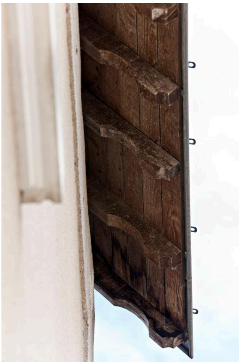
Détail des coyaux dits à queue de renard.
