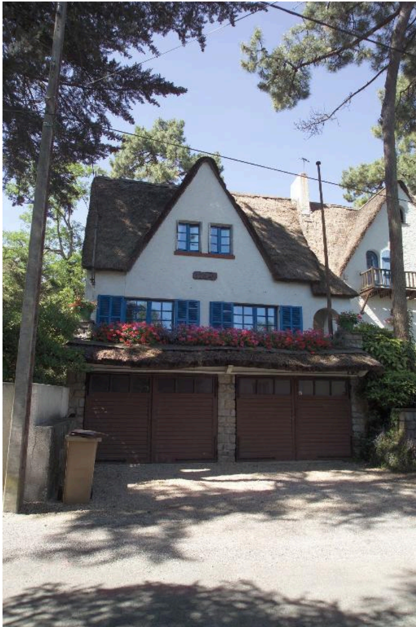
Vue de détail de la façade, avenue de Sesmaisons.
