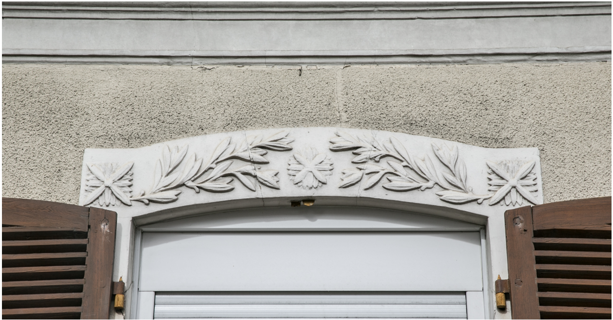
Un détail d'un linteau sculpté, rue Ledru-Rollin.
