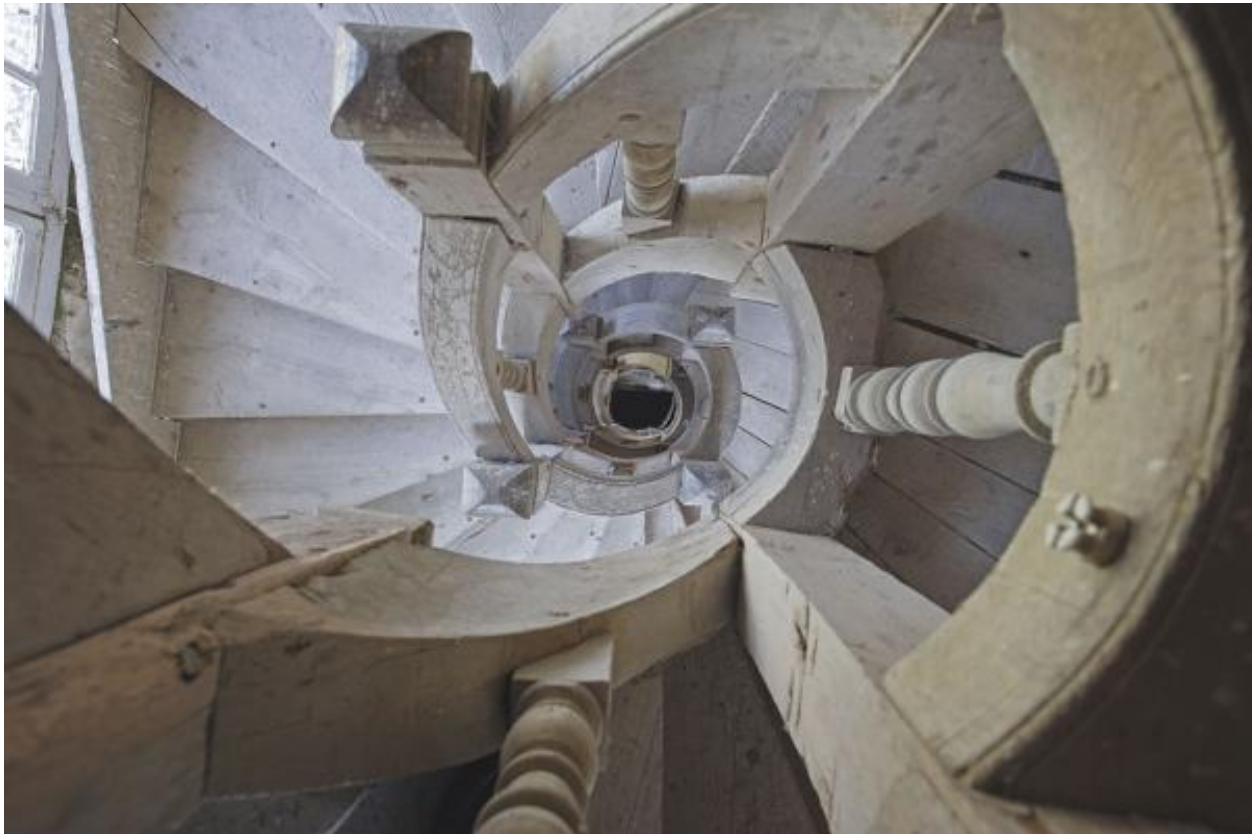
L'escalier secondaire du pavillon nord.
