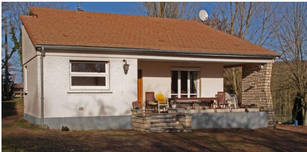
Façade sud. Cuisine sur la gauche. Séjour à droite.
