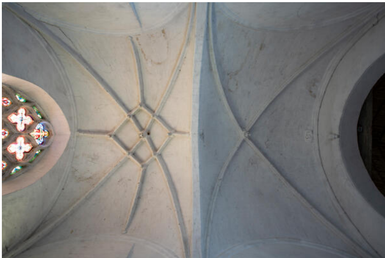
Voûtes du chœur.
