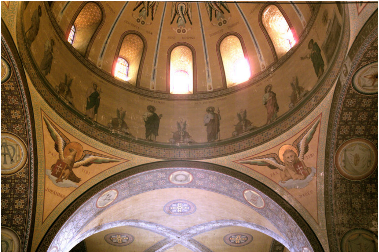
Le tambour, détail de la partie est.
