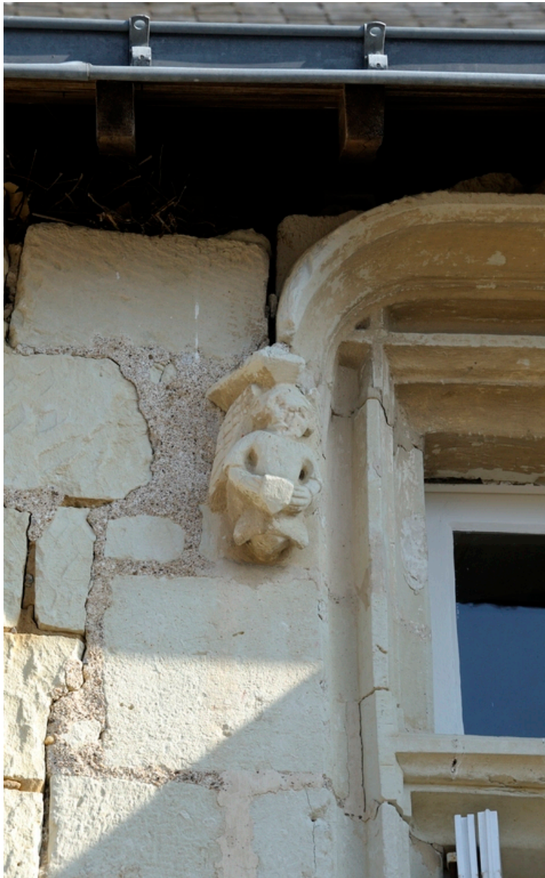
Logis. Manoir médiéval. Façade sud, larmier de la fenêtre haute (est), détail du culot sculpté (gauche), ange.
