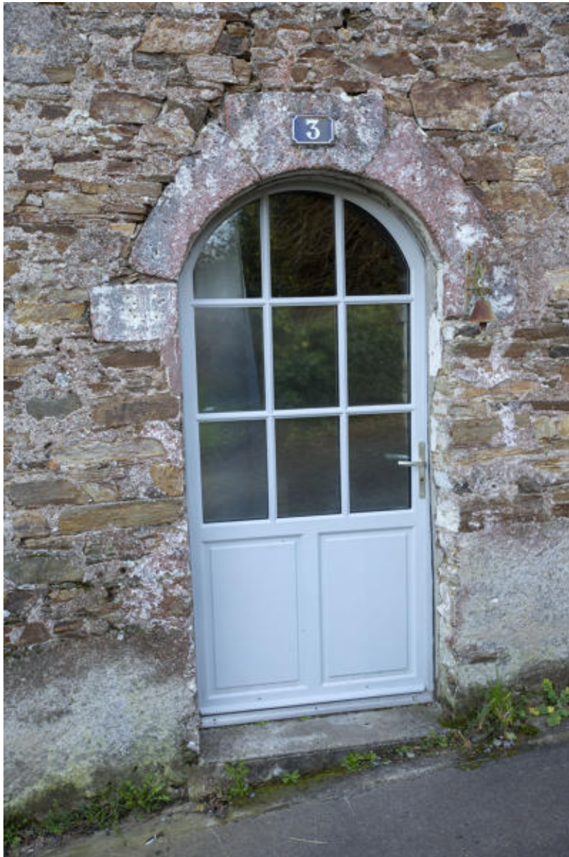
Maison, 3 rue du Port Navalo. détail de la porte d'entrée.
