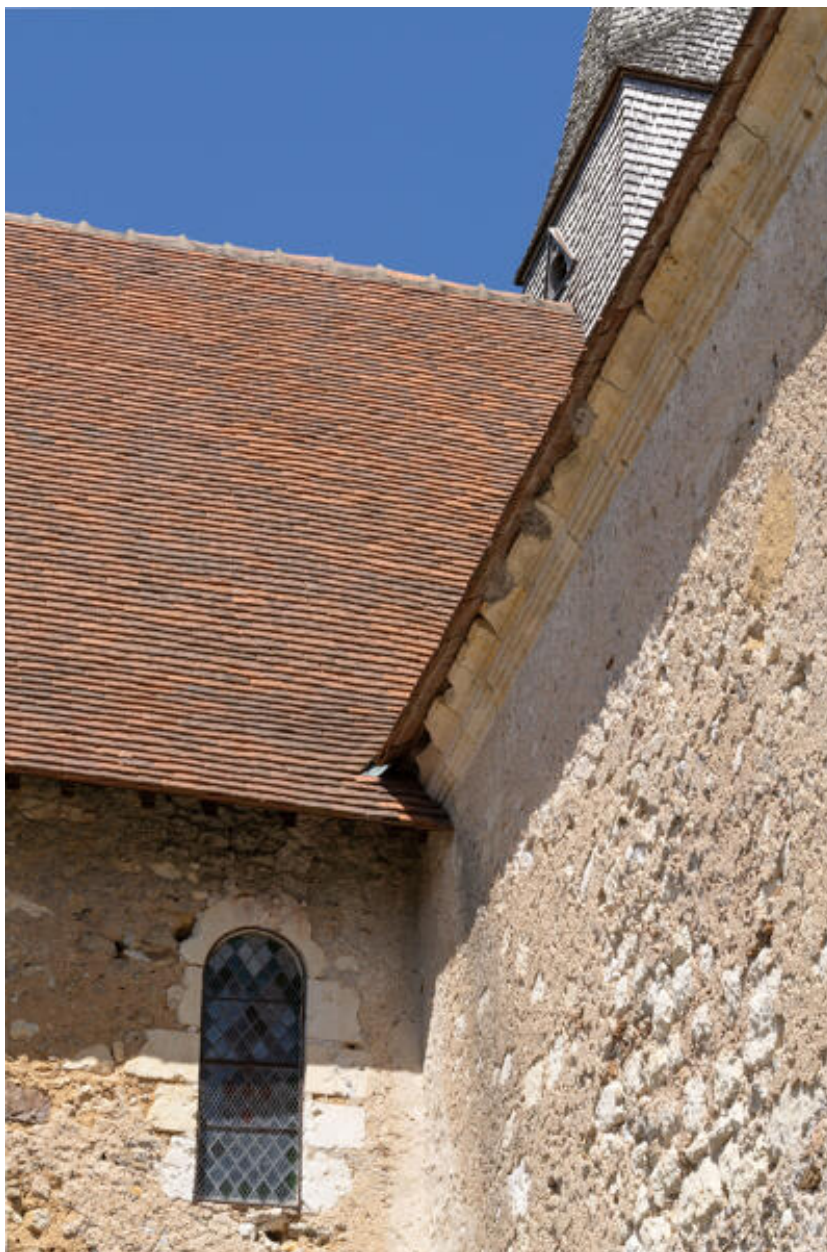
Raccordement de la chapelle latérale et de la nef, côté sud-ouest.
