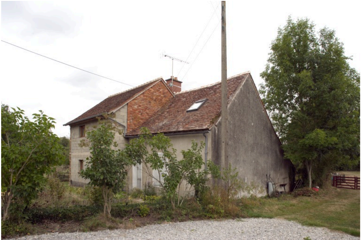
Vue depuis le sud-ouest.
