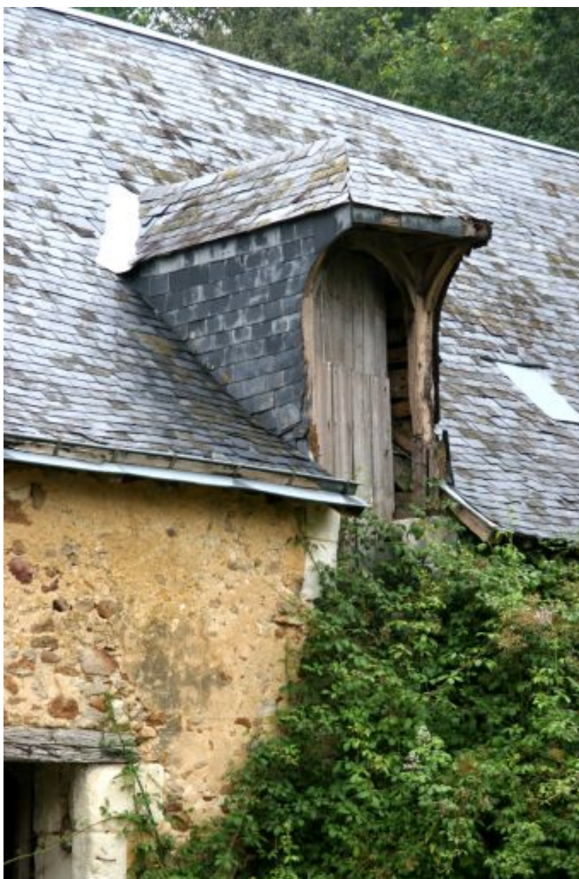
Grange-étable : lucarne passante.
