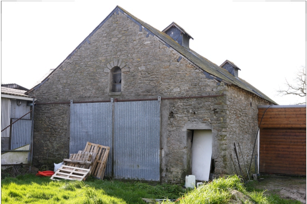
Vue du pignon nord de l'étable.
