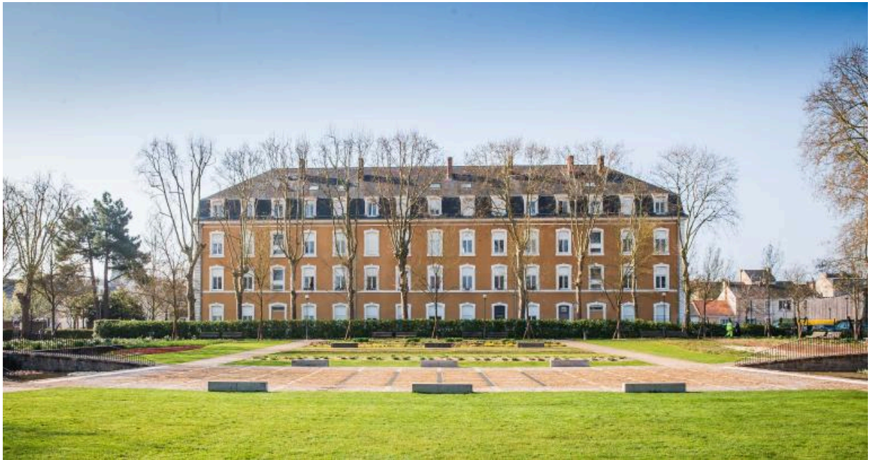
Vue de la caserne dite Chanzy depuis le nord.
