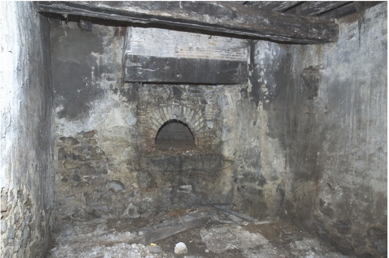
Intérieur du logis, rez-de-chaussée, pièce nord-ouest : le four à pain.
