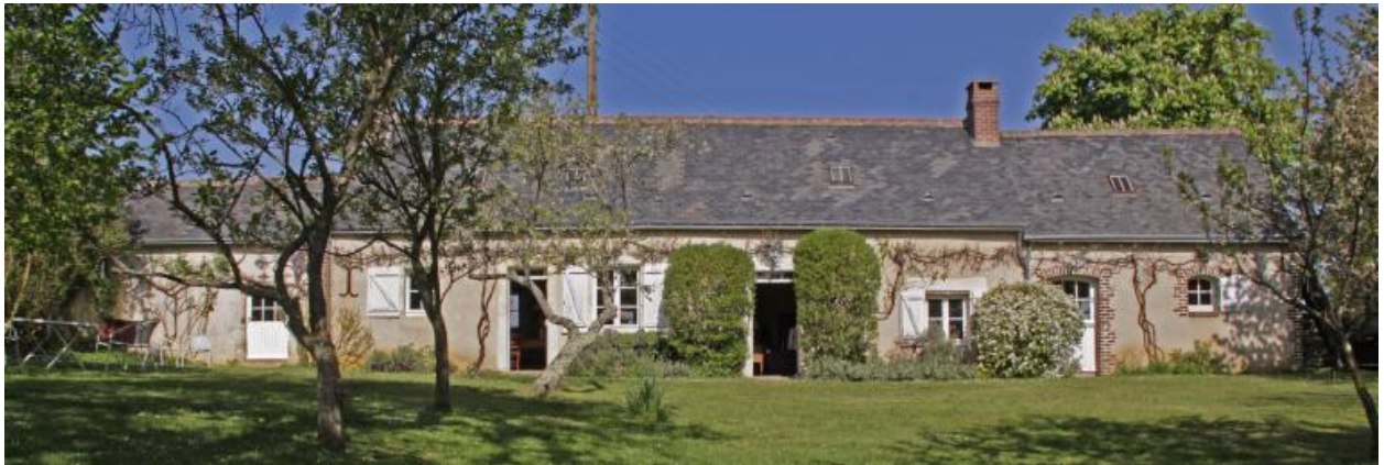
Ferme bloc à terre. La Castillonnerie.
