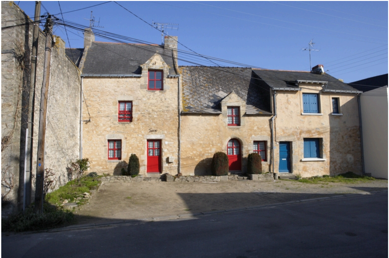
Vue des n° 5 et 7 rue de l'Aire.
