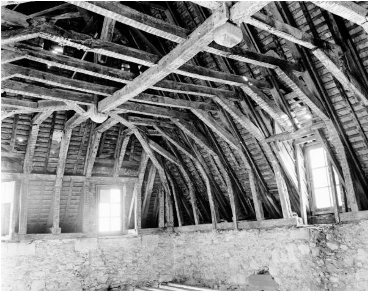
Aile orientale : étage de comble, vue d'ensemble, en axe sud-ouest/nord-est.
