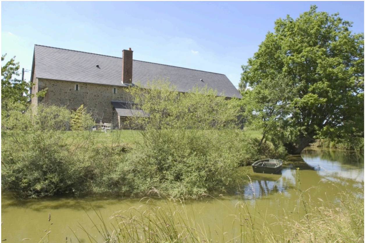
La douve et l'étable-fournil vues depuis l'est.
