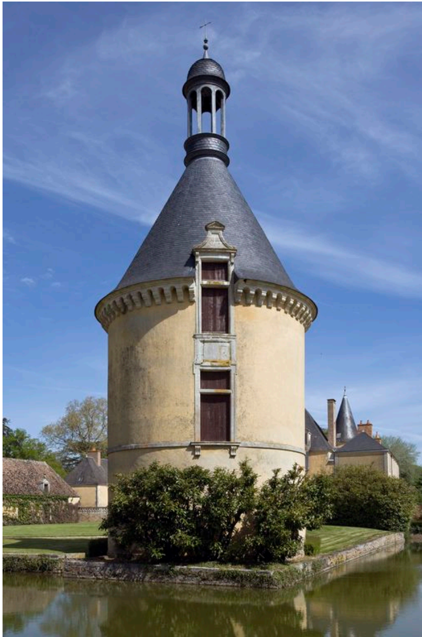
Tour de la basse-cour vue depuis le sud.
