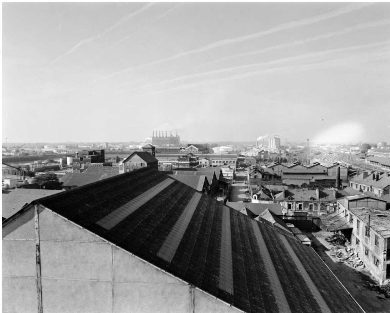
Vue du paysage vers l'aval depuis le 6e étage du bâtiment de fabrication central, avec la centrale de Cheviré à l'horizon.
