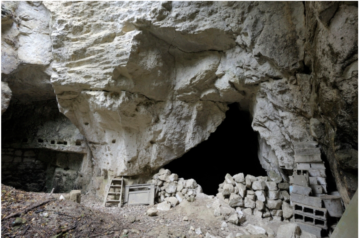
Fontis en partie postérieure de l'abri troglodytique. Anciennes dépendances et galerie de carrière (2).
