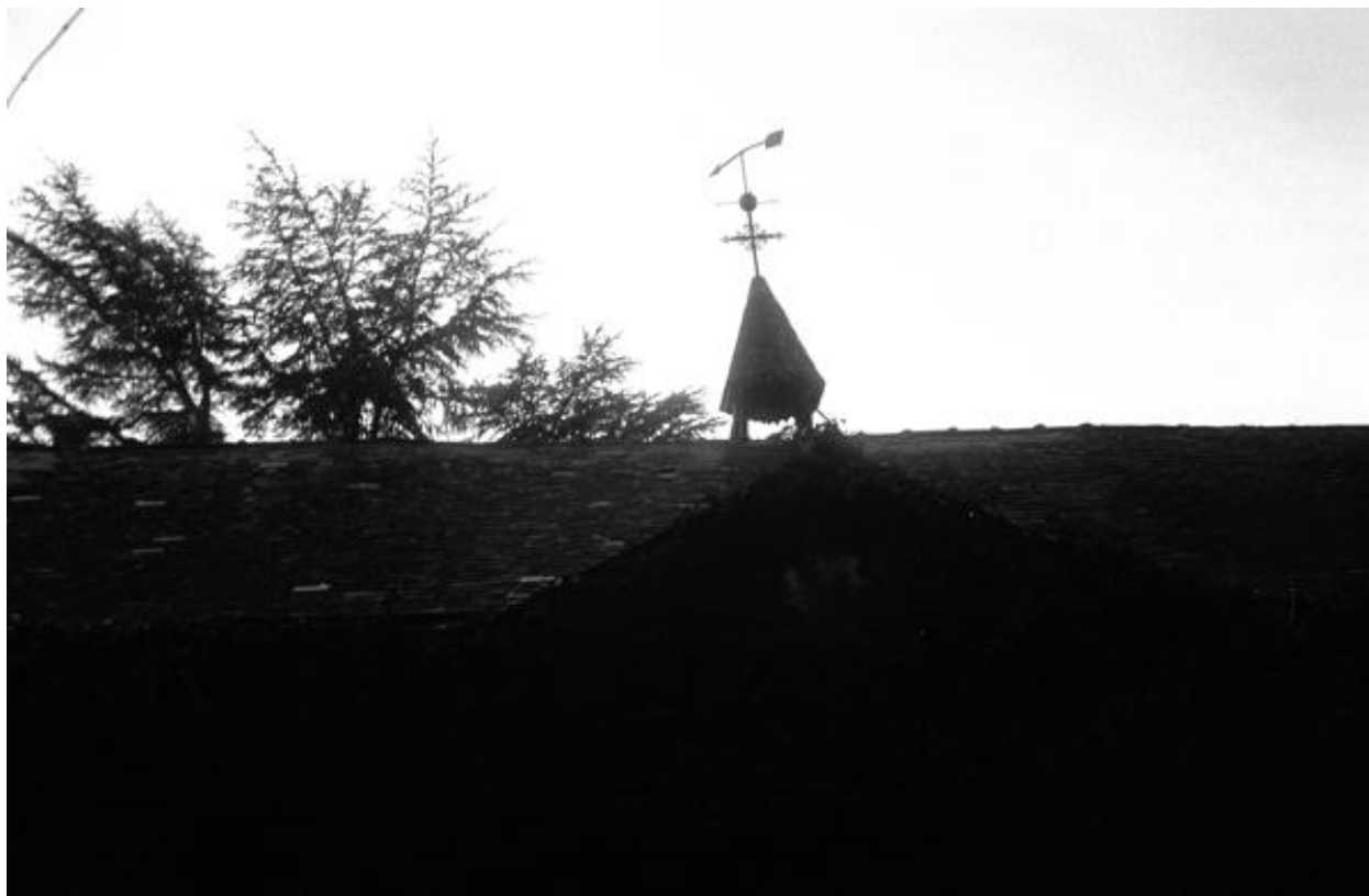
Détail de la toiture.
