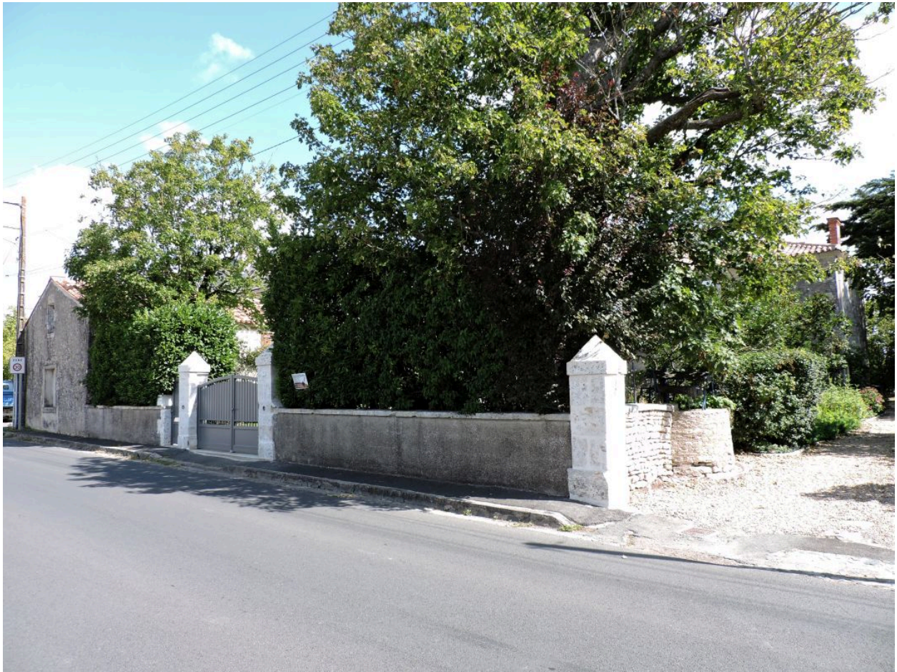
La propriété vue depuis le sud.
