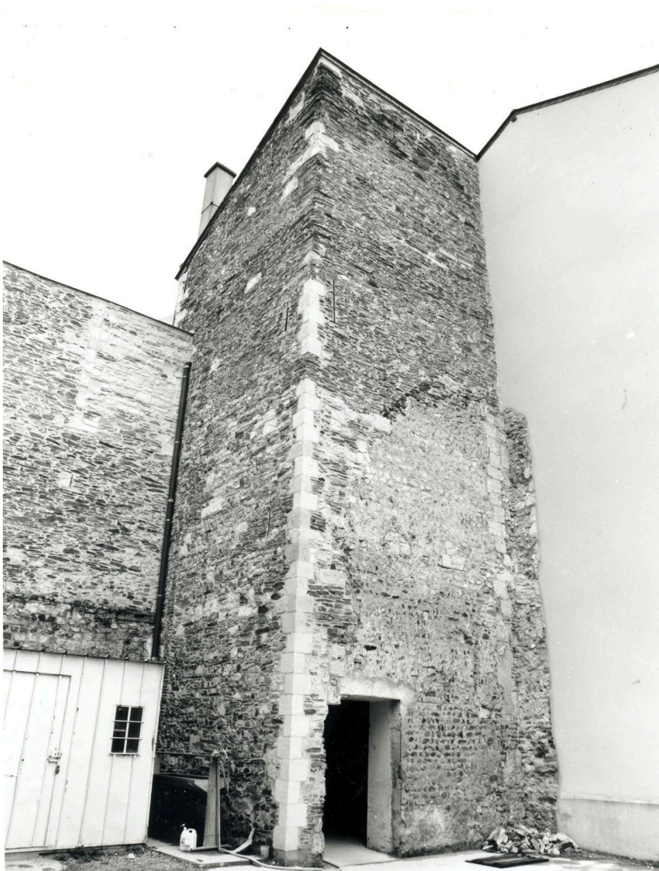
Collégiale Saint-Martin, bas-côté nord, angle antérieur gauche : vestiges des élévations extérieures en partie basse. A la jonction du pignon enduit du 23, rue Saint-Martin, arrachements de l'ancien porche.
