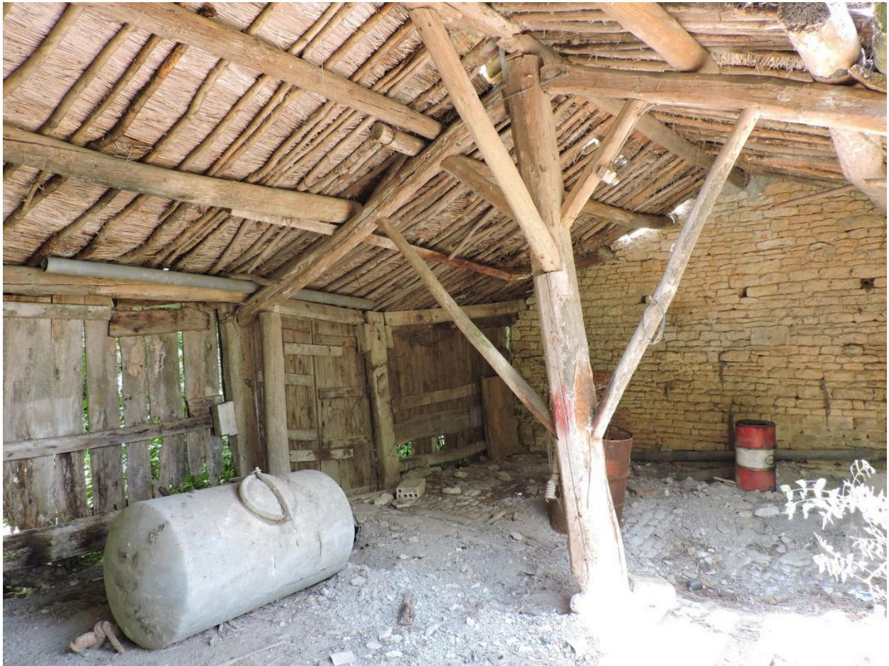
Vue intérieure de la grange-étable.
