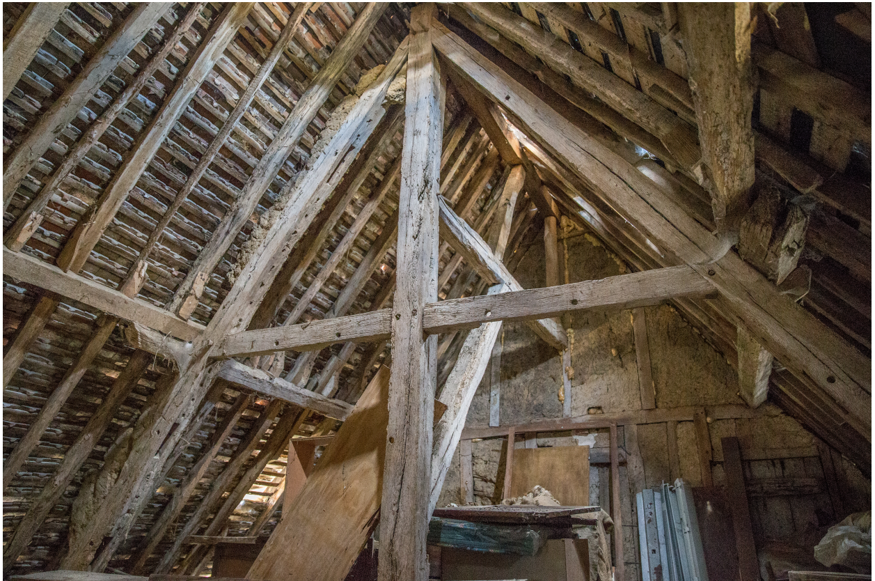
Le comble et la charpente du logement.
