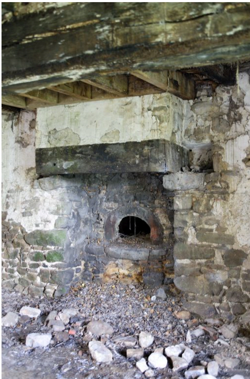
Rez-de-chaussée, pièce sud : la cheminée.
