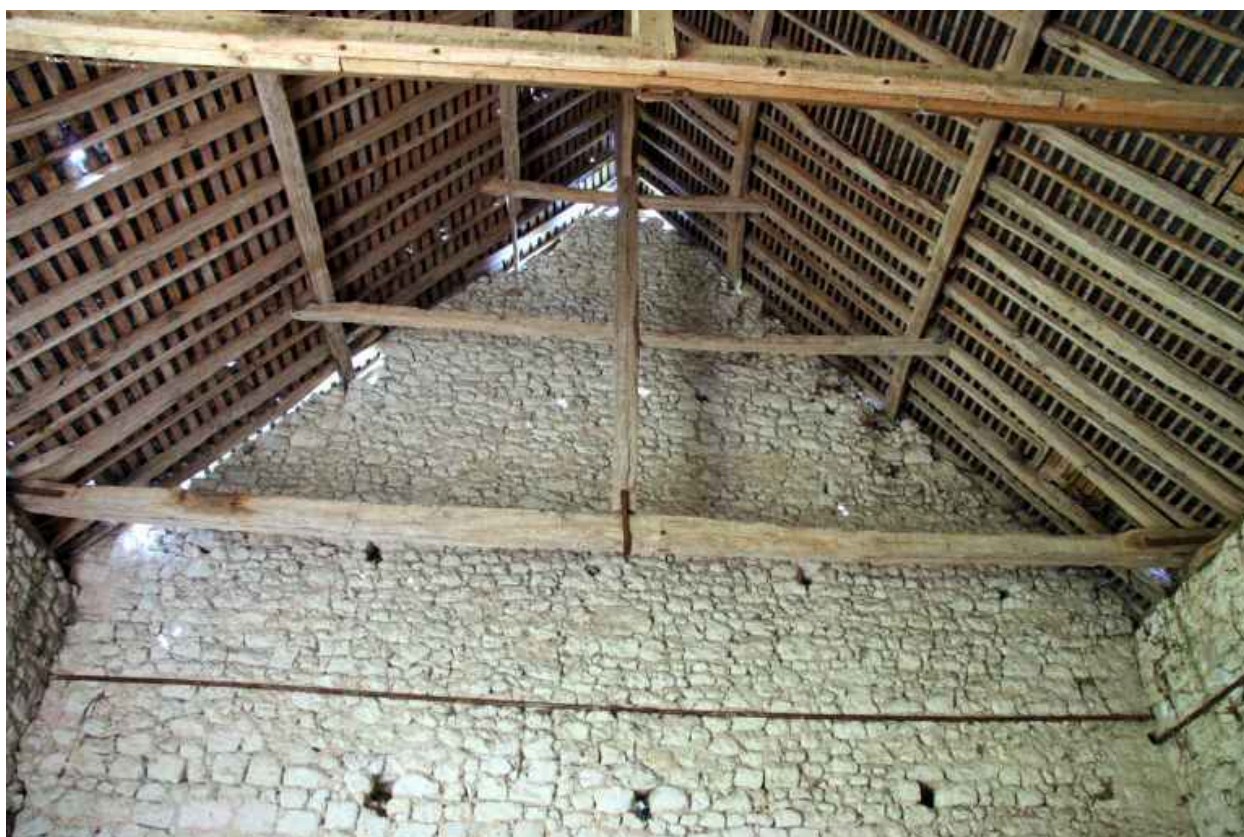
La grange : charpente à pannes.
