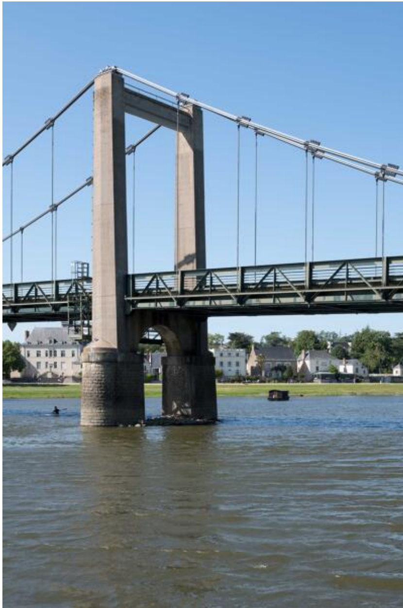
Détail d'un pylône en béton.
