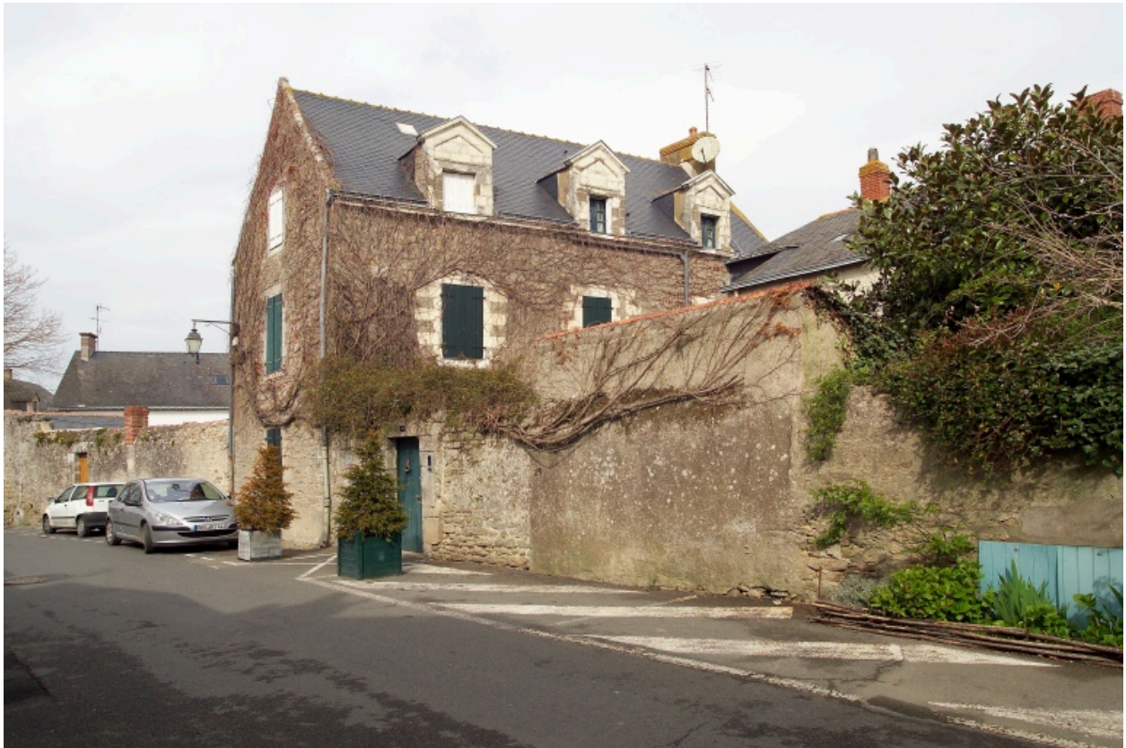
Vue de la partie perpendiculaire à la rue.
