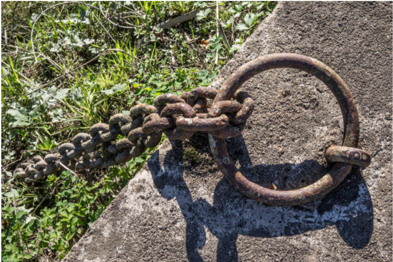
Vue d'un organeau de la chaussée.
