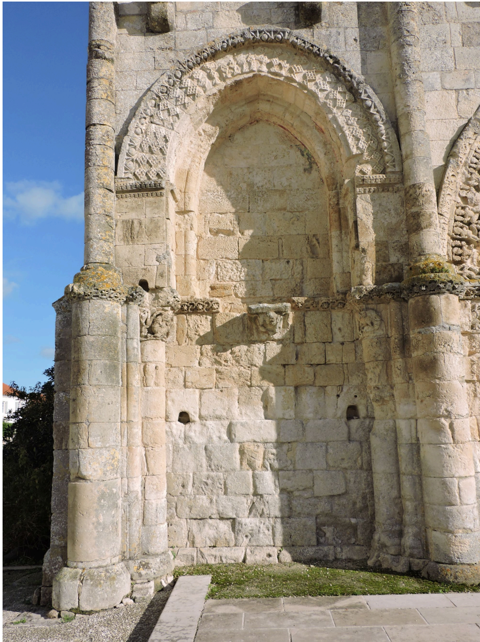
Façade occidentale : arcature nord.
