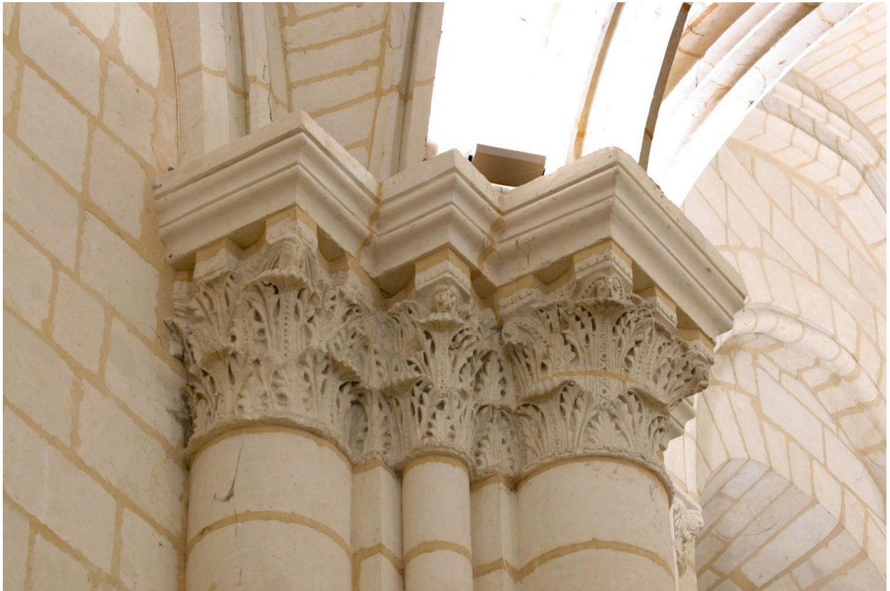
Chapelle Saint-Eloi. Nef, première travée, pile nord-est : groupe de chapiteaux à feuillages.
