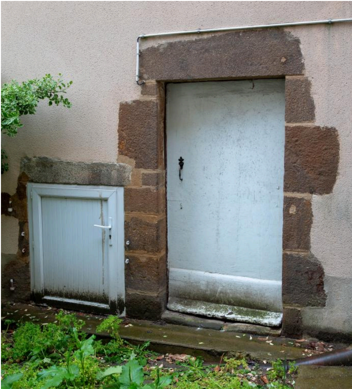
Ouvertures en grès roussard, façade arrière du bâtiment central du presbytère.
