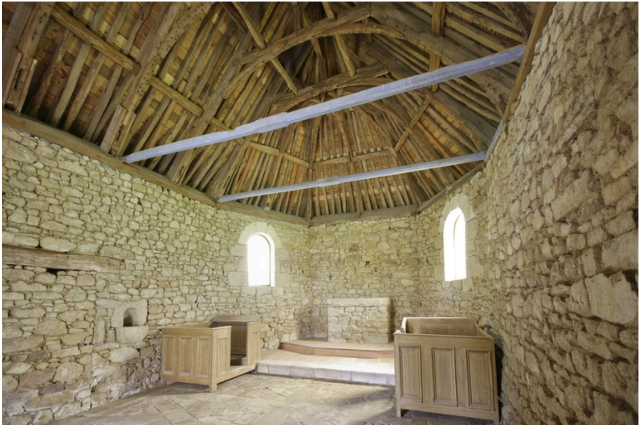
Chapelle. Vue de l'intérieur depuis l'ouest.
