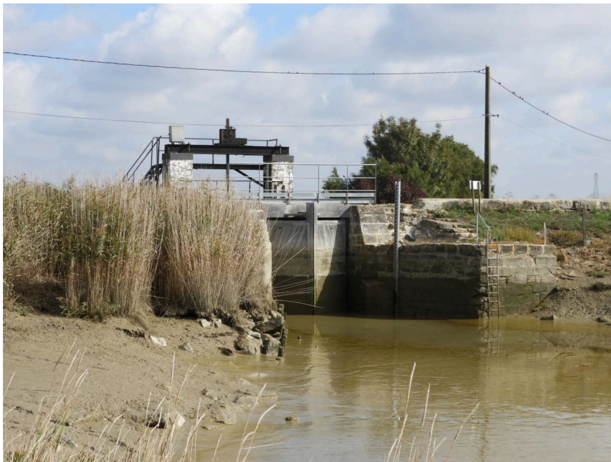
La porte vue depuis le sud-ouest, côté aval.
