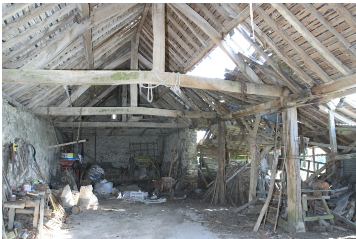
La charpente de la remise.
