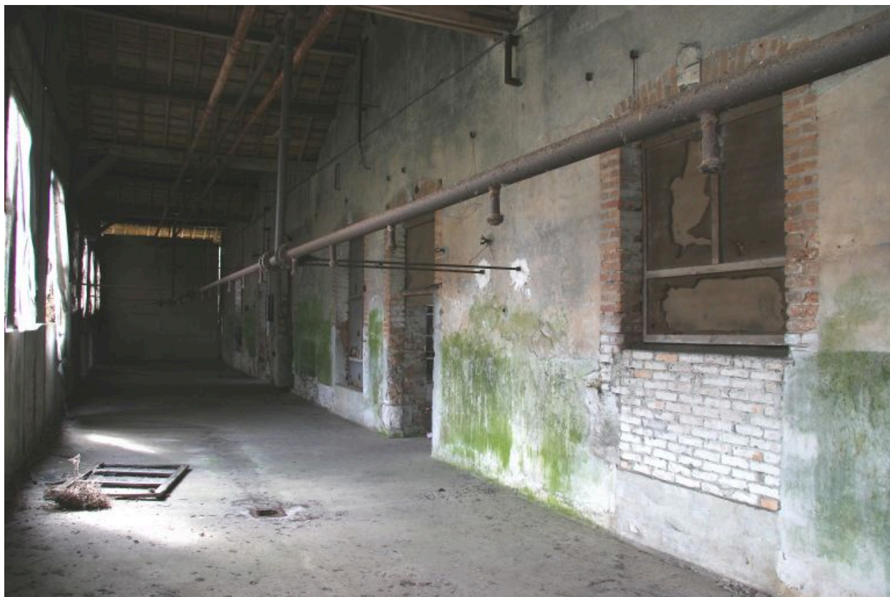
Etage, construction en brique sur le bief : douches collectives.
