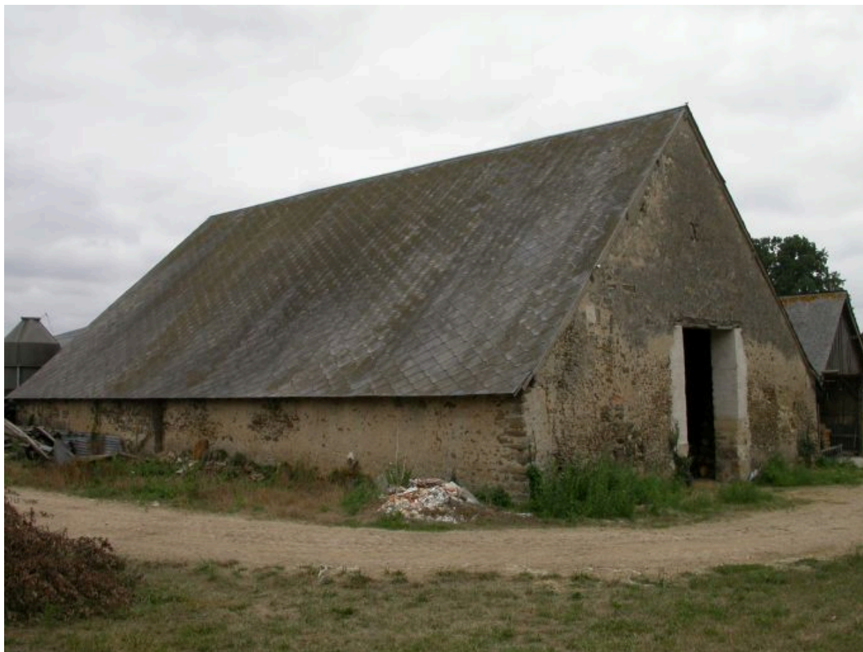
La grange : vue de volume.
