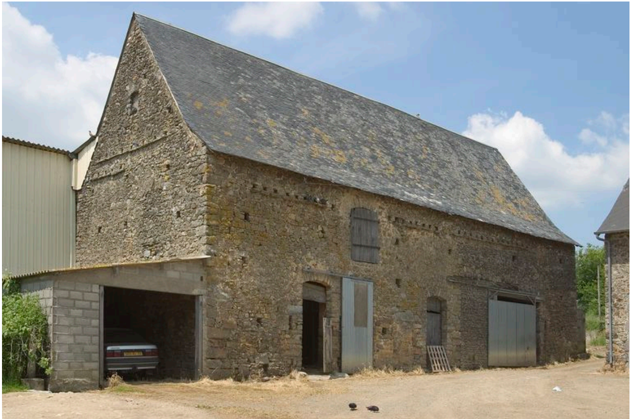
L'ancienne écurie. Façade principale et mur-pignon sud.
