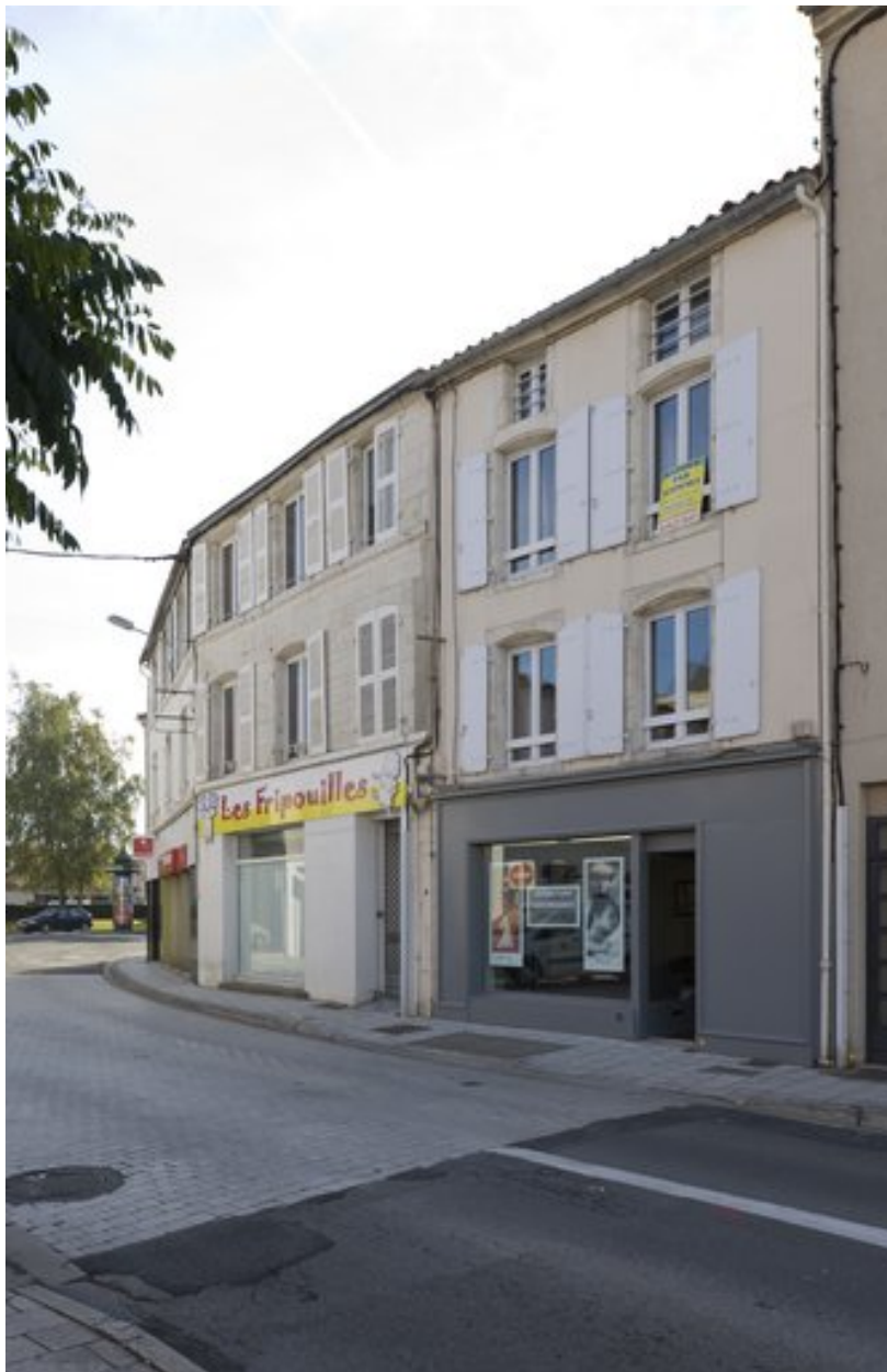
Façades des maisons 28 et 26, place des Acacias.
