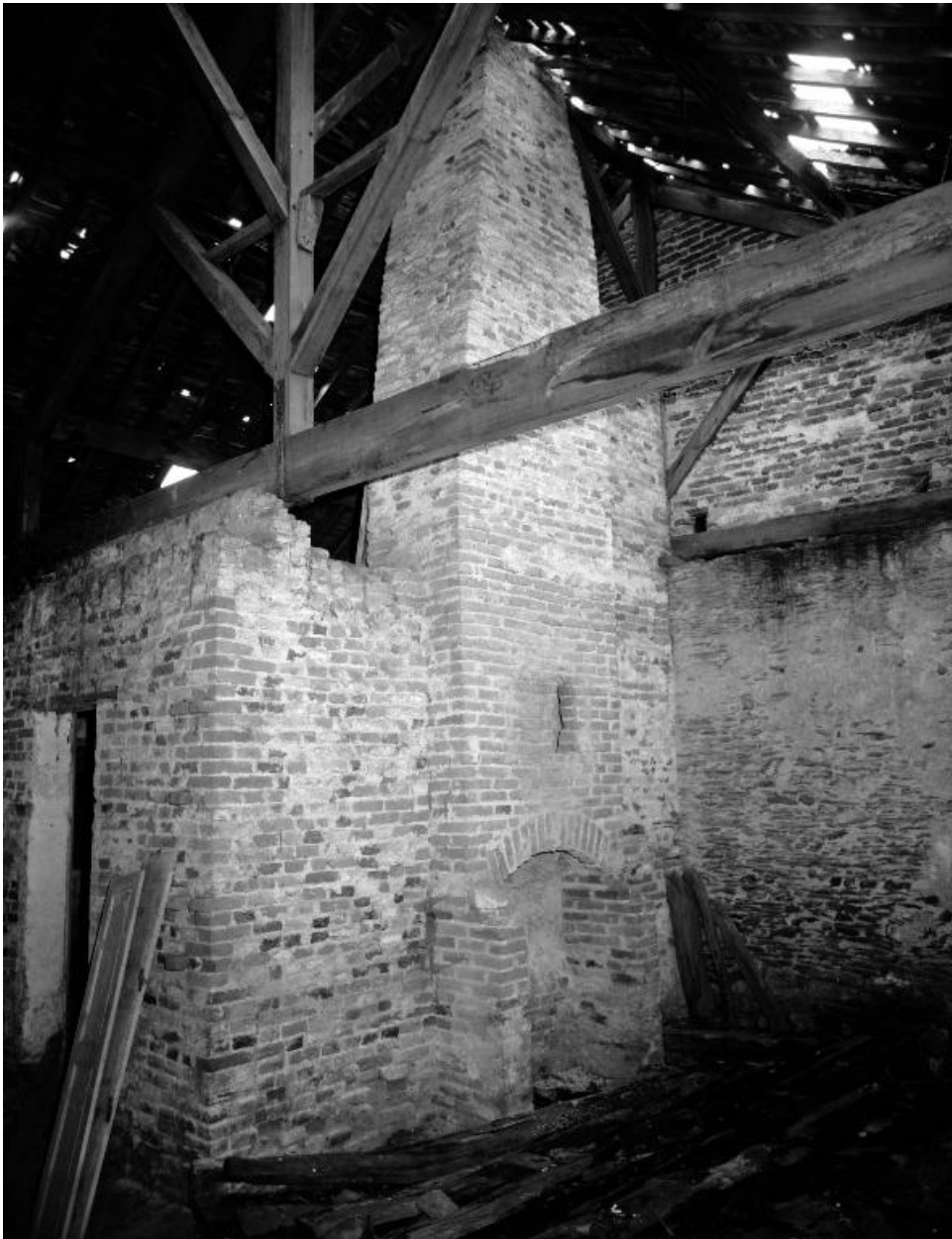
Magasin à coke transformé en maisons d'ouvriers (1984, ?).
