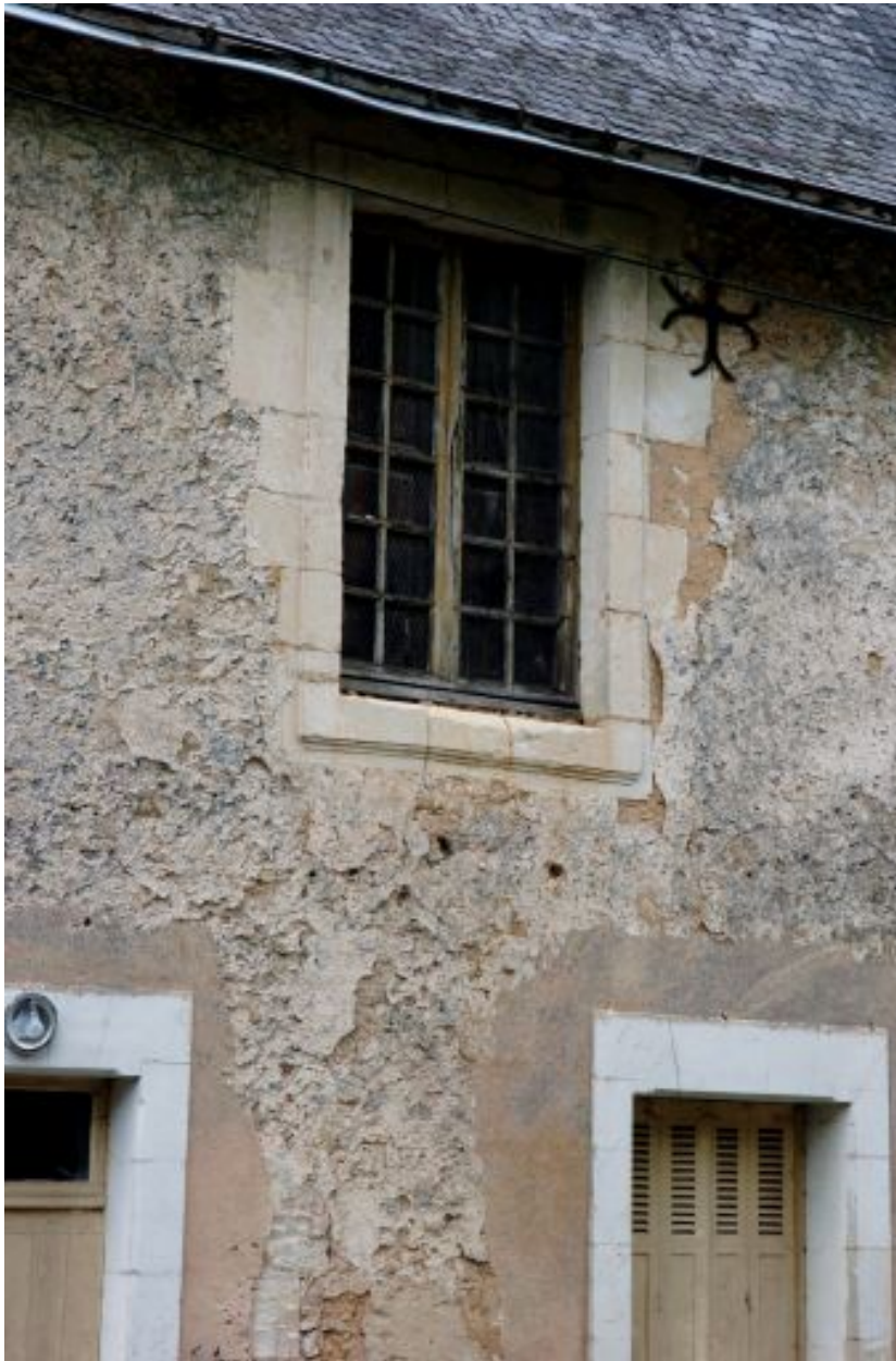
Façade postérieure : baie.
