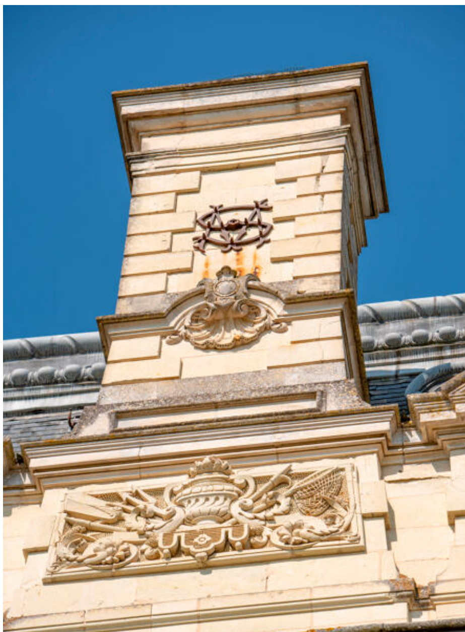
Le pavillon sud-est, souche de cheminée.
