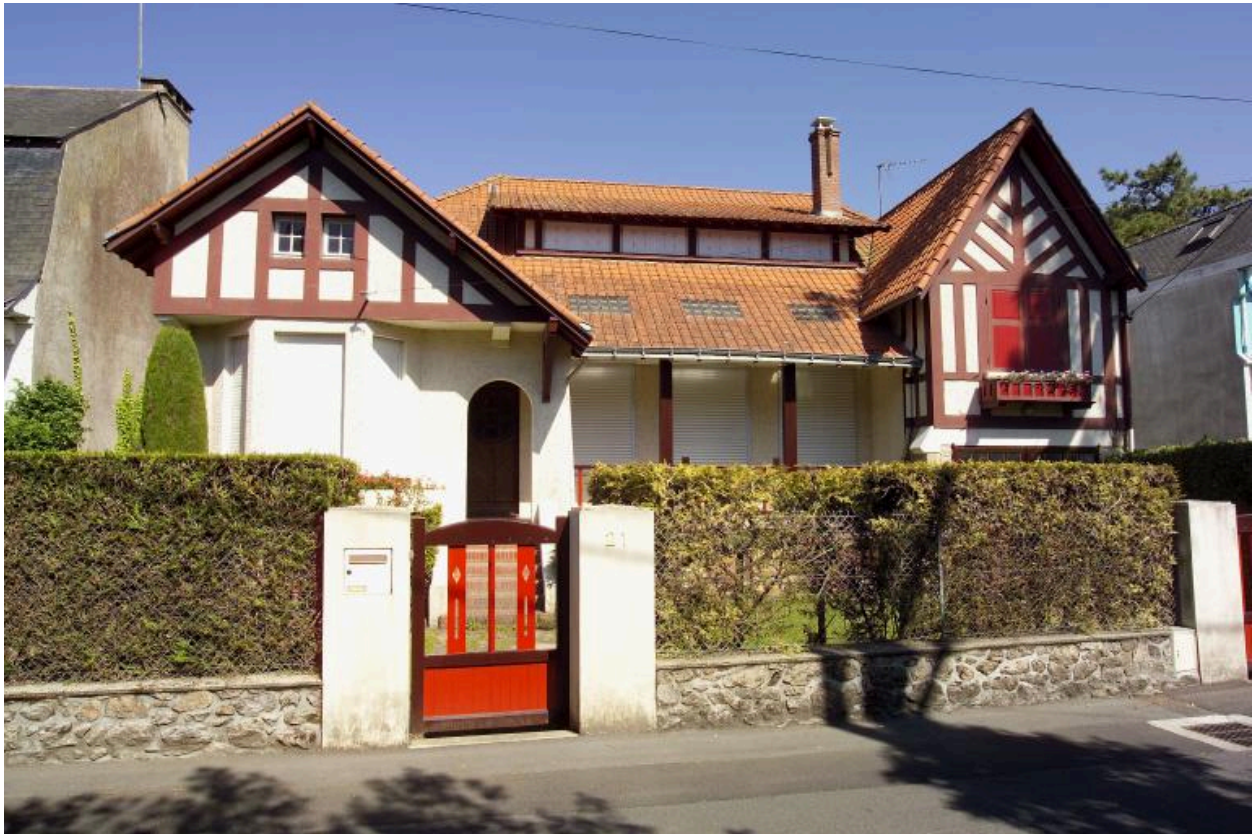
Vue d'ensemble de la villa Normanni.
