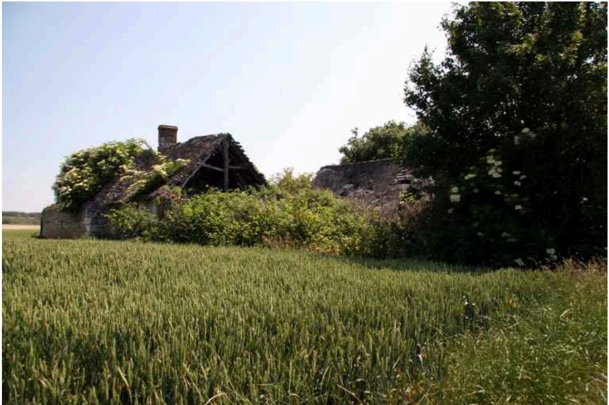
La Cheminée : vue d'ensemble.
